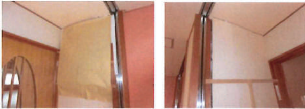
図 4. 園舎の内壁破損を補強している箇所
