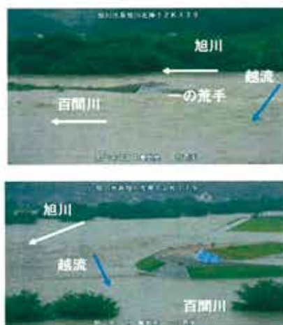
図-4 一の荒手の越流状況 7/7 6:30 (上写真:下流側, 下写真:上流側)
