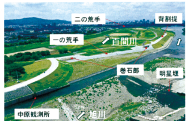
図-1 洪水後の分流部の様子 (旭川左岸：12.2KP 付近)
