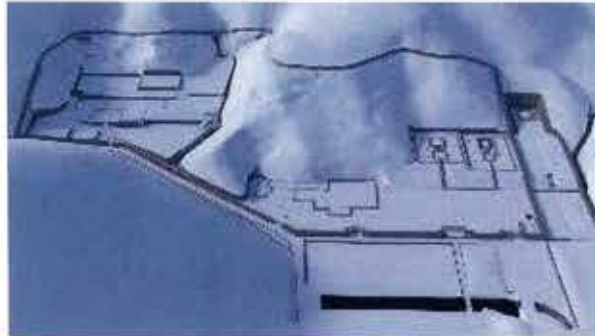
図3 南上空からの全景 自然地形に沿って外周の石塀が廻り、石塀によって囲われた構内に、造成のための切土部分の石積、盛り土部分の石積、建築基礎、それぞれに付随する水路が走る。講堂周辺と広庭の東端には吸込み井戸が点在する。
