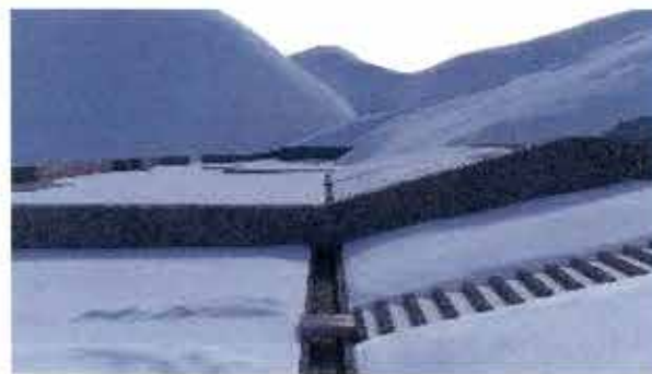
図6 領域を横断する水路。椿山から神社・聖廟方向を見る。斜面の水は東西に走る水路を東に流れて、椿山と神社の間の石塀の下を潜り抜けて、椿山東側の水路に至る。
