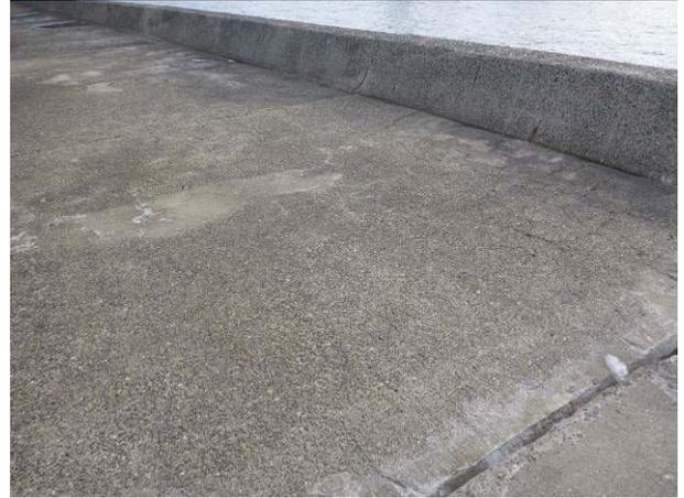
写真－３ 防波堤コンクリートのひび割れ
