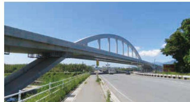
新名神高速道路 朝明川橋
