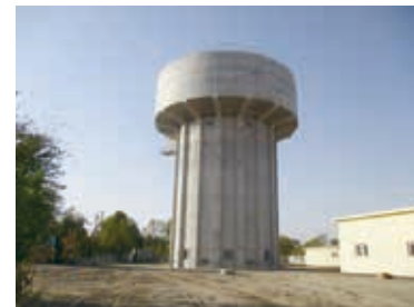
1,800m³ 高架水槽
