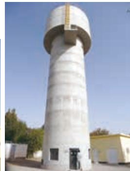
250m³ 高架水槽
