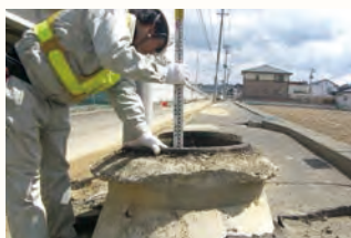
東日本大震災における緊急対応(下水道の点検・調査)
