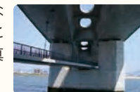
橋下につられた歩道橋
