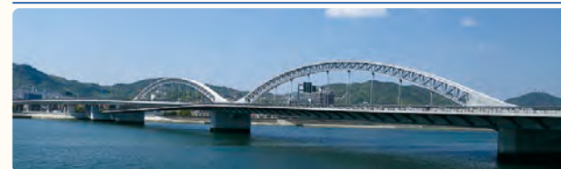
太田川大橋全景
