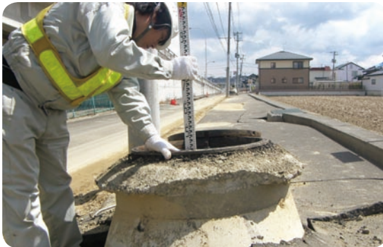
▲災害査定設計へ向けた下水道管路の調査の様子
