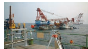
羽田空港 拡張工事施工管理
