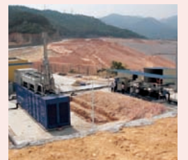
発電所(左奥が管理棟、左手前がガスエンジン)
