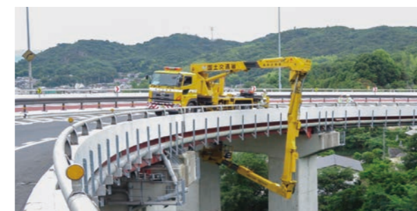
橋梁点検作業
