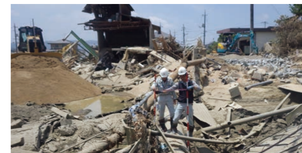
2018年 西日本豪雨被災現場調査
