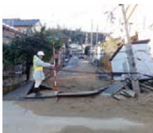
液状化により被災した道路の調査
