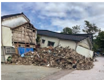
被災した河川護岸の調査
