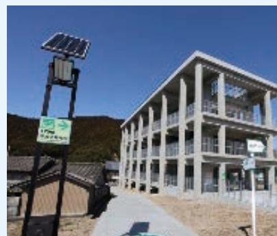
南海トラフ地震に備えた津波避難タワーの新設(徳島県) 地元自主防災会と協議しながら、ハード対策とソフト対策の両面を実施
