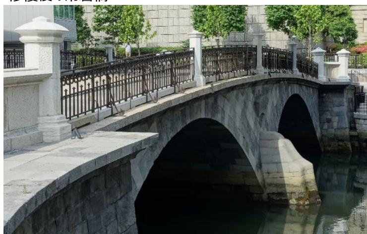
修復後の常盤橋
