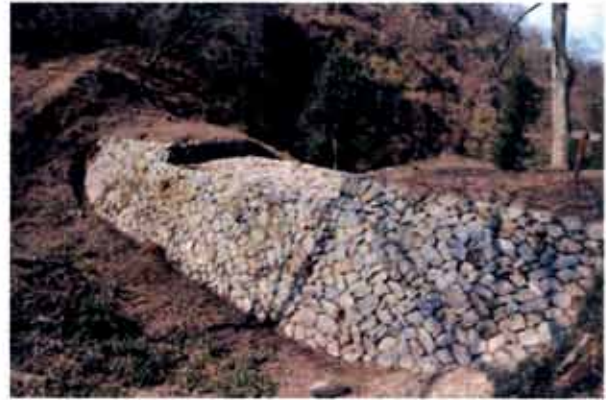
写真-7 上流面の石積が見える八番砂留（上流側）
