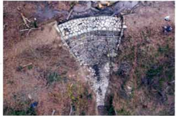
写真-8 アーチ状の九番砂留（ドローンによる空撮）
