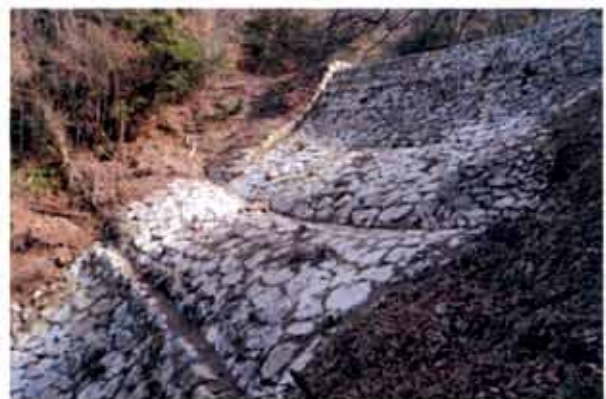
写真-10 自然の斜面に沿った石積の十番砂留（上部）
