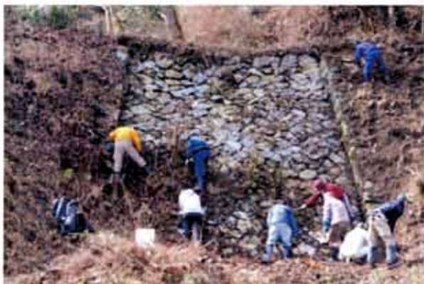
写真-1 整備作業の様子 (五番砂留)
