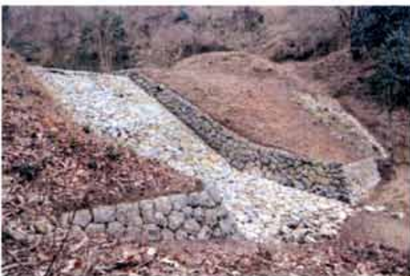
写真-6 水通しの勾配が変化している八番砂留（下流側）
