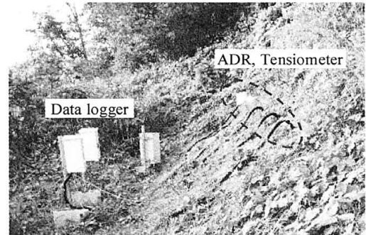
図-5 観測機器設置状況(斜面2)
