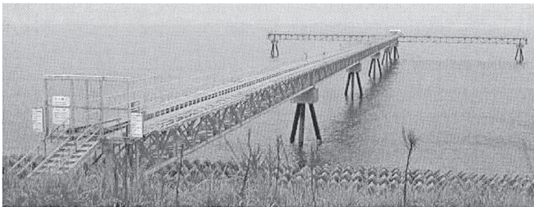
図1 大潟波浪観測所の観測栈橋
