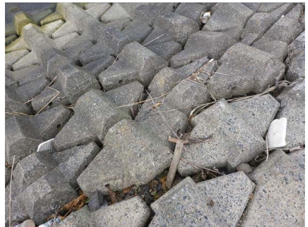
写真-43 八浜付近の堤防
