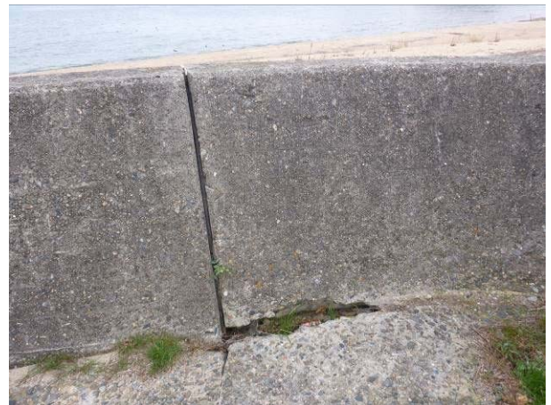
写真-27 大入海岸付近の防潮堤
