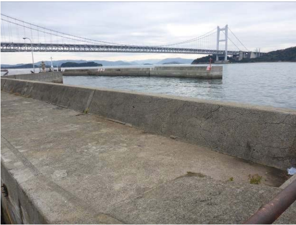
写真-13 下津井港付近の防潮堤
