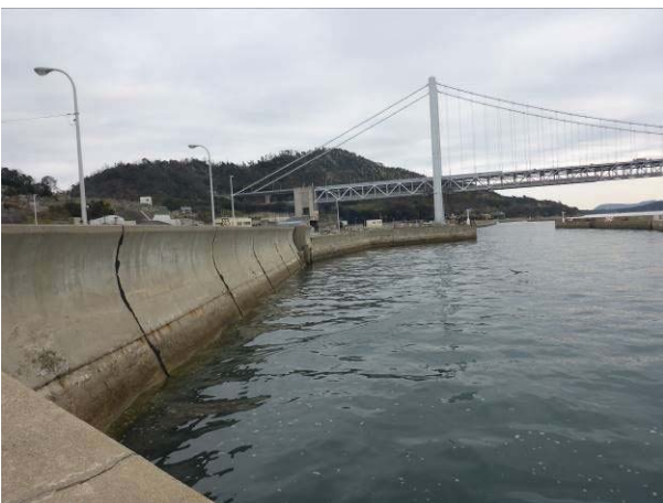
写真-11 防潮堤に見られるひび割れ
