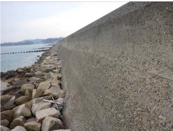
写真-31 防潮堤の外観
