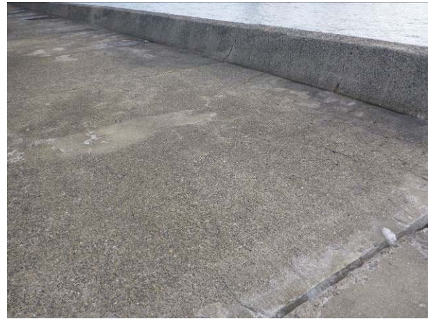
写真-3 防波堤コンクリートのひび割れ
