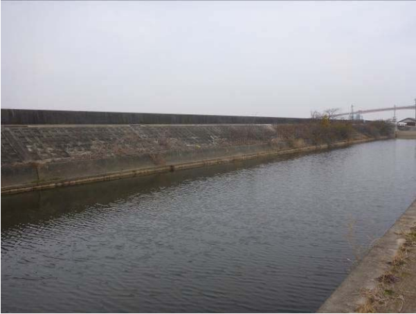
写真-40 郡付近の防潮堤
