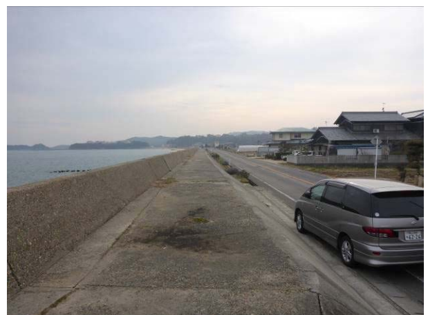
写真-28 玉野市番田～岡山市南区小串の防潮堤の全景
