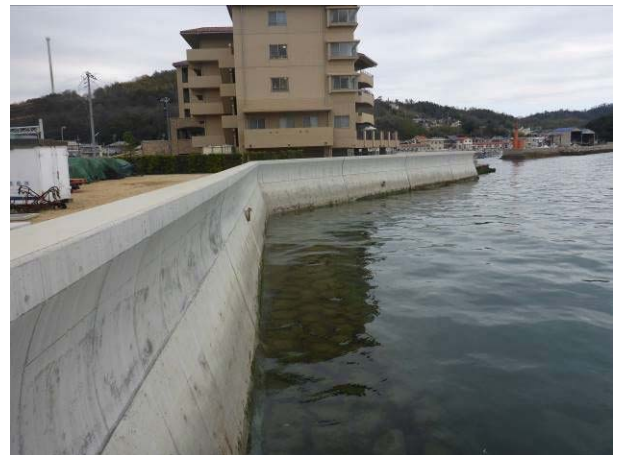
写真-22 下津井港の整備された防潮堤
