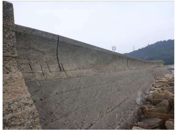
写真-30 防潮堤の外観
