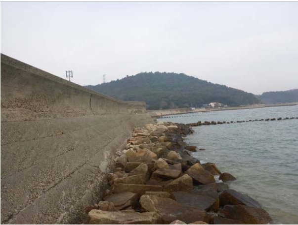
写真-29 防潮堤の外観
