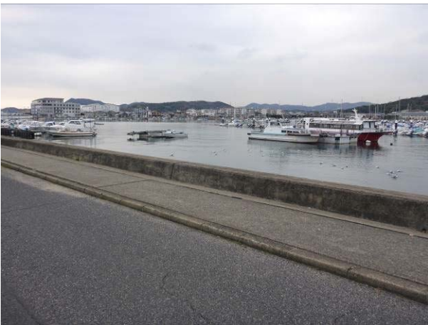
写真-15 琴浦港付近の防潮堤
