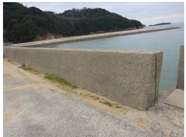
写真-6 防潮堤に見られる表面の侵食
