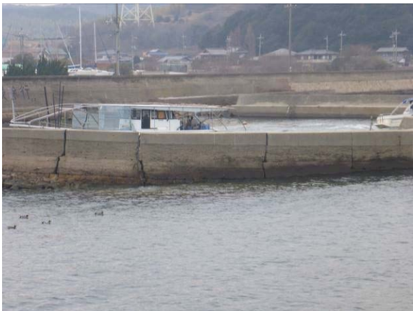
写真-38 小串付近の防波堤
