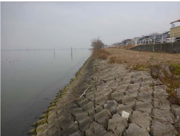
写真-42 八浜付近の堤防
