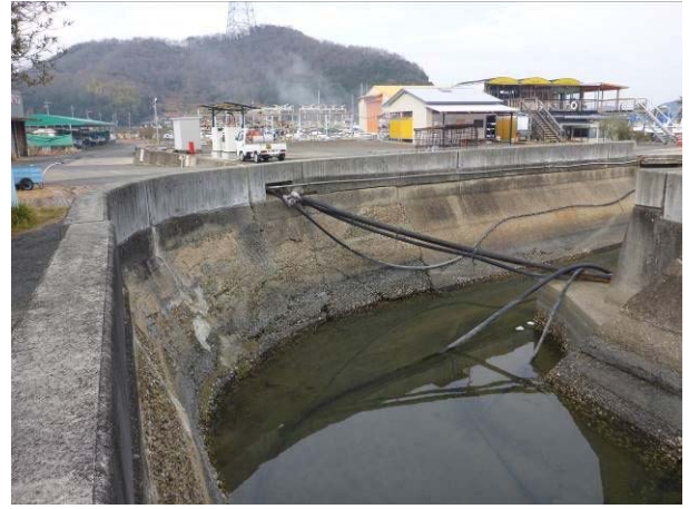
写真-37 小串付近の堤防
