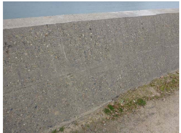
写真-5 防潮堤に見られる表面の侵食
