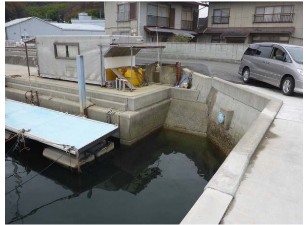
写真-14 旧コンクリートの劣化状況
