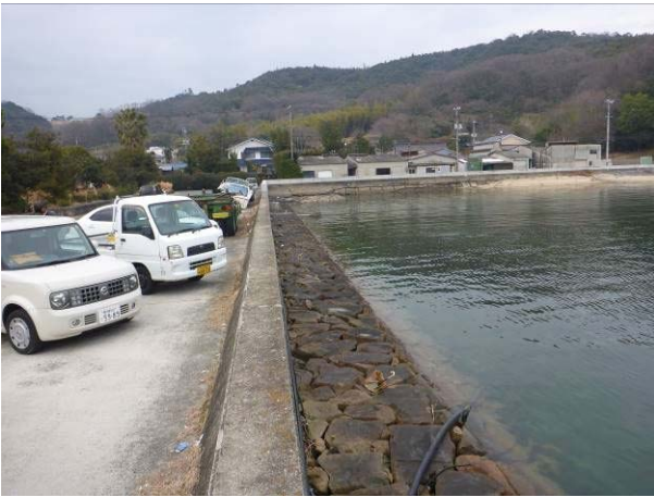
写真-24 山田港付近の防潮堤
