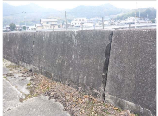
写真-39 宮浦付近の防潮堤
