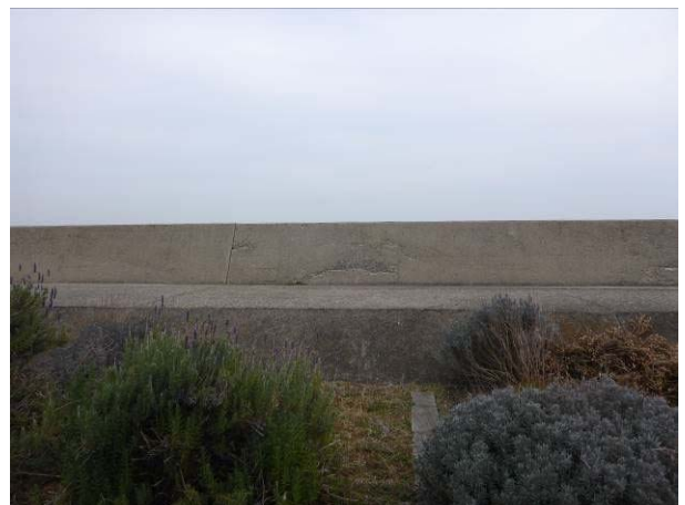
写真-34 防潮堤の表面に見られる施工不良
