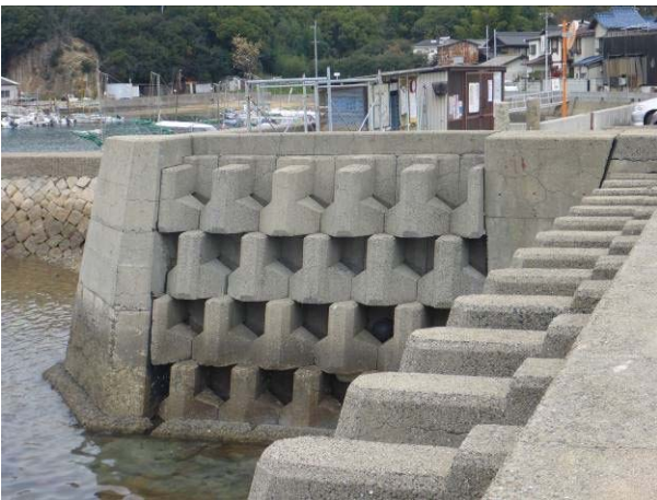
写真-9 防潮堤に見られるひび割れ
