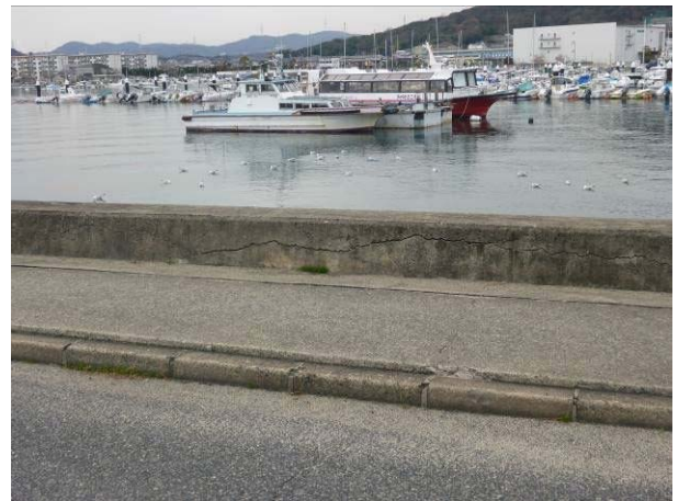
写真-16 琴浦の防波堤に見られるひび割れ
