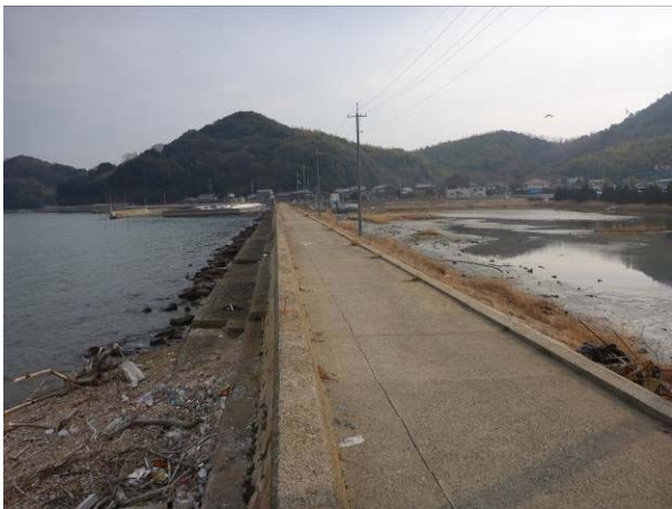
写真-36 小串付近の防潮堤
