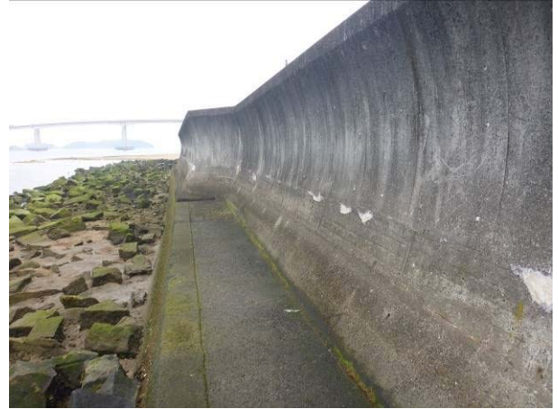
写真-41 郡付近の防潮堤
