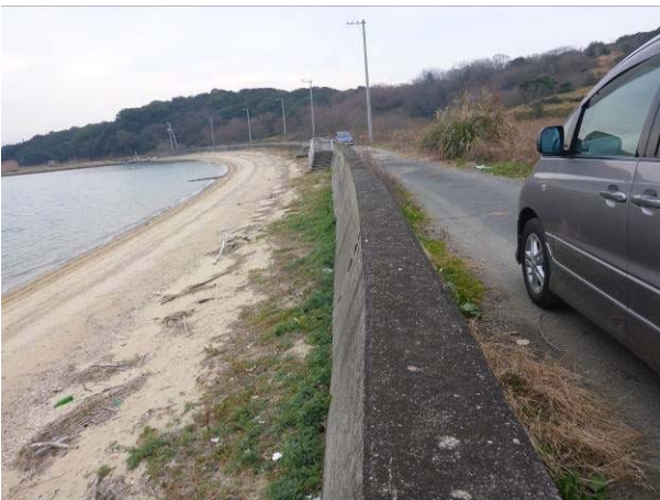
写真-26 大入海岸付近の防潮堤
