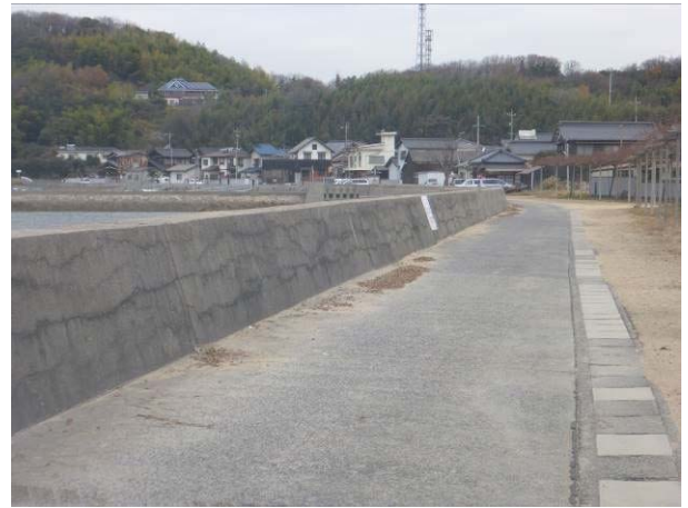
写真-8 防潮堤に見られるひび割れ
