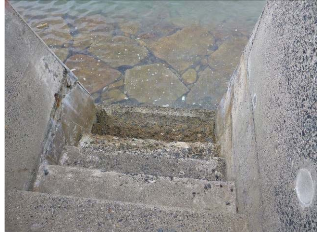
写真-10 防潮堤に見られるひび割れ
