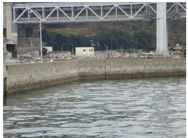
写真-12 防潮堤に見られるひび割れ
