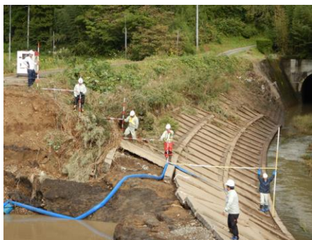
破堤箇所の被害状況調査の状況(高倉川)
