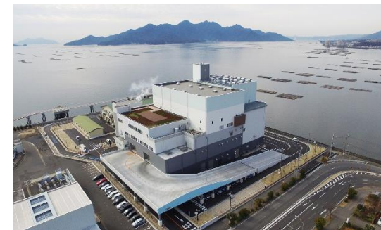
はつかいちエネルギーセンター(廿日市市)
