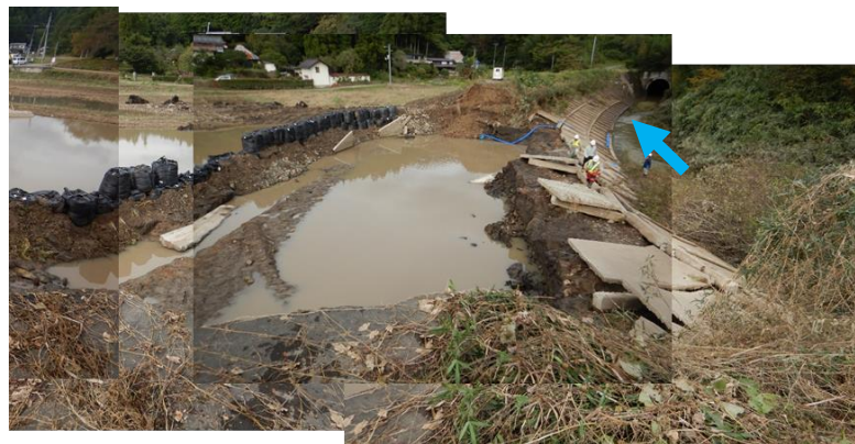
破堤箇所の被害状況調査の状況(高倉川)
