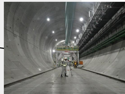
東京外かく環状道路
