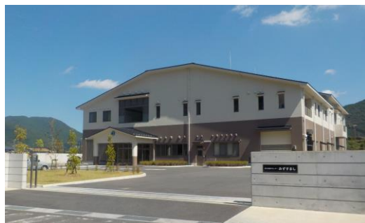
西予市衛生センター(愛媛県)
