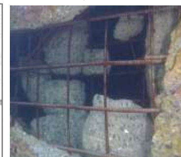
ROV による コンクリートの劣化状況調査
