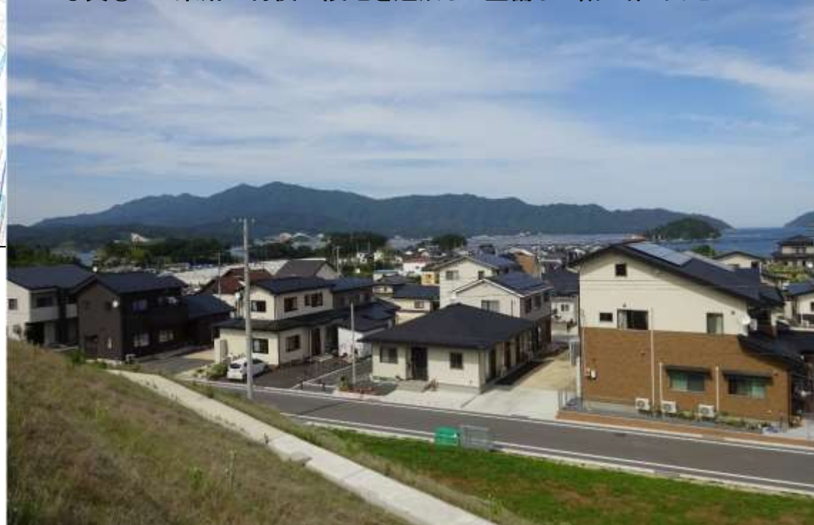
写真② 旧集落の背後丘陵地を造成して整備した織笠第1団地
