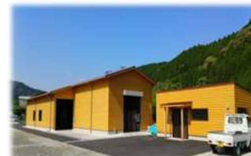
【 那賀ウッド工場 】
