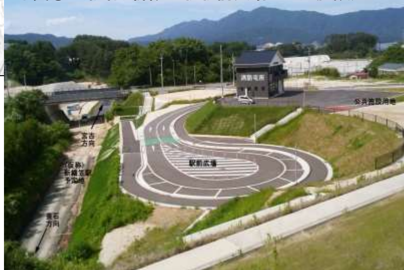
写真① (仮称)新織笠駅駅前広場と公共施設用地
